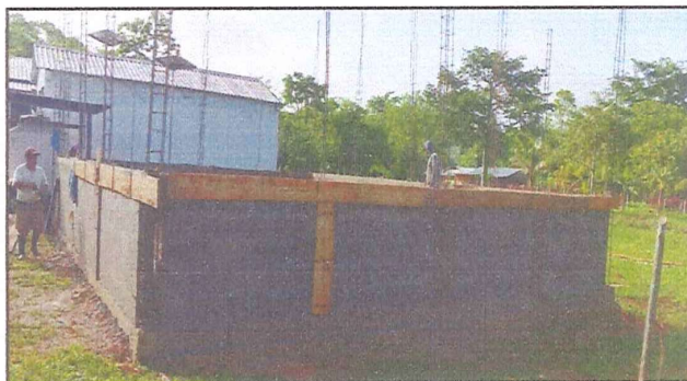
Foto 4: Levantamiento primera fase de pared
