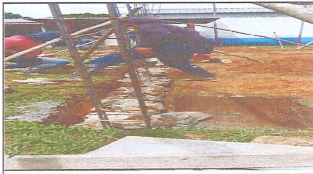
Foto 2: Levantamiento de cimiento
