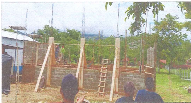
Foto 6: Fundicion de columnas en las partes que tiene pared
