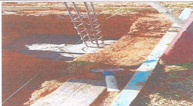
Foto 1: Colocación de columnas en las esquinas
