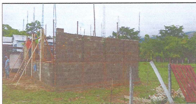
Foto 5: Levantamiento segunda fase de pared despues de solera.
